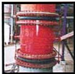
所有的管道系统，无论是工业还是市政领域，都要考虑减震及位移的问题。橡胶弹性接头可以完善地解决这个问题。宜华的弹性橡胶接头采用优质纤维及弹性材料制造而成，而且
